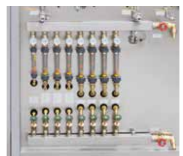
Circuit d'eau de refroidissement
